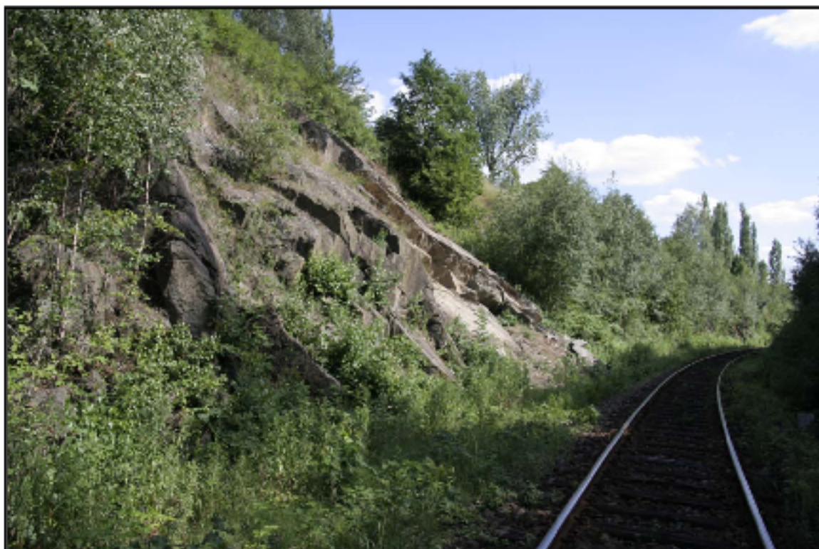
Obr. 13 – Další problémová část východního skalního svahu, pohled proti směru staničení, směr Studenec, nutnost očistění a odštěpení volných kamenů a bloků, v pozadí vzrostlá vegetace charakteru náletových dřevin
