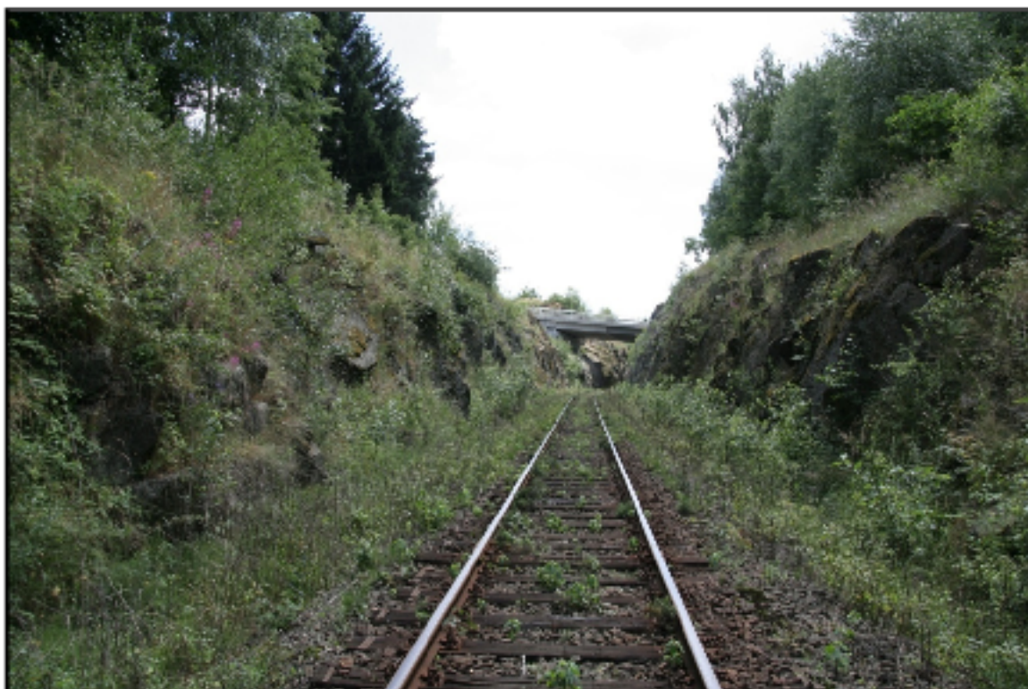
Obr. 01 – Pohled z konce úseku, směr Studenec, v pozadí je vidět sibiřský most
