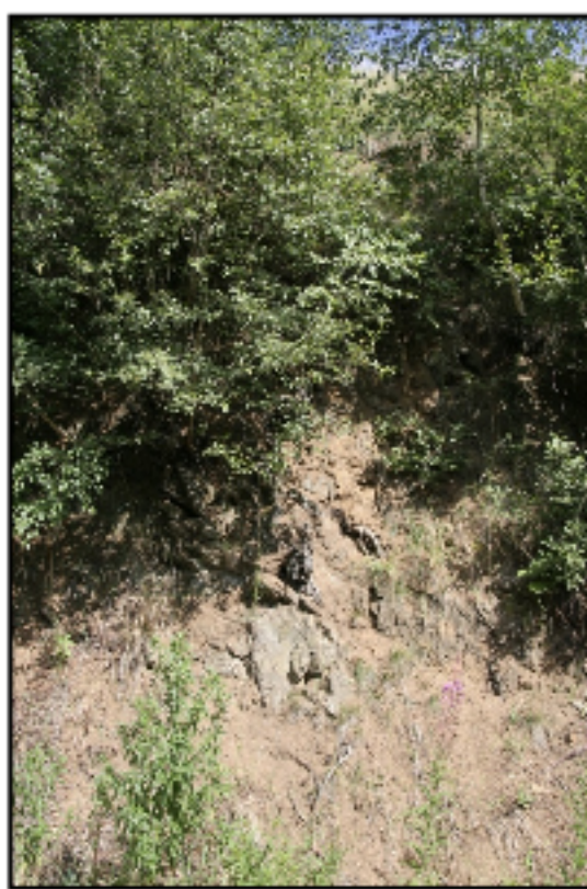
Obr. 07 – Viditelné projevy působení srážkové vody, západní svah, směr Křižanov
