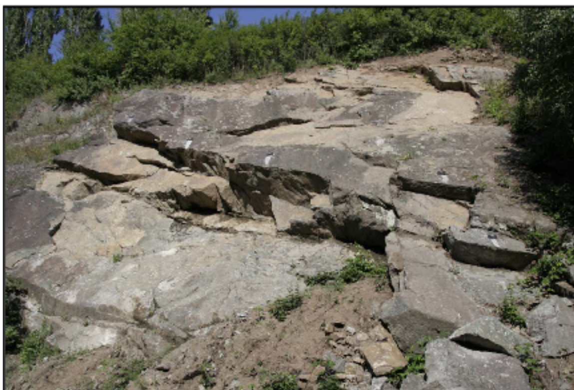
Obr. 14 – Detailnější zobrazení na povrchu části východního skalního svahu, je zde dobře patrný směr a tloušťka ploch odlučnosti v porovnaní odvozené roviny
