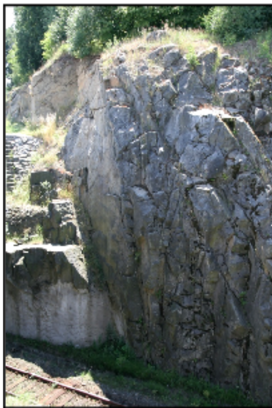
Obr. 05 – Pohled na skalní výchoz, západní svah, za sítučním mostem, ve směru staničení
