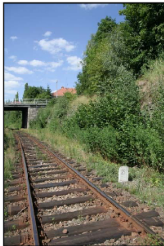
Obr. 09 – Výchozí svah u přeč. železničního mostem, směr Křižanov, ve směru staničení
