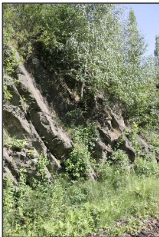
Obr. 11 – Pohled na spodní partii východního svahu, směr Křižanov
