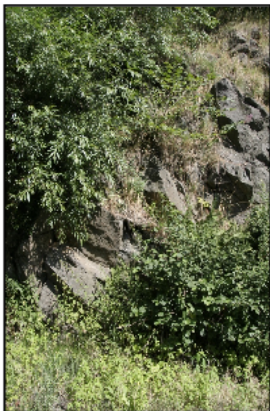
Obr. 06 – Pohled na výchozí poloskalní svah v oblasti začátku úseku, směr Křižanov
