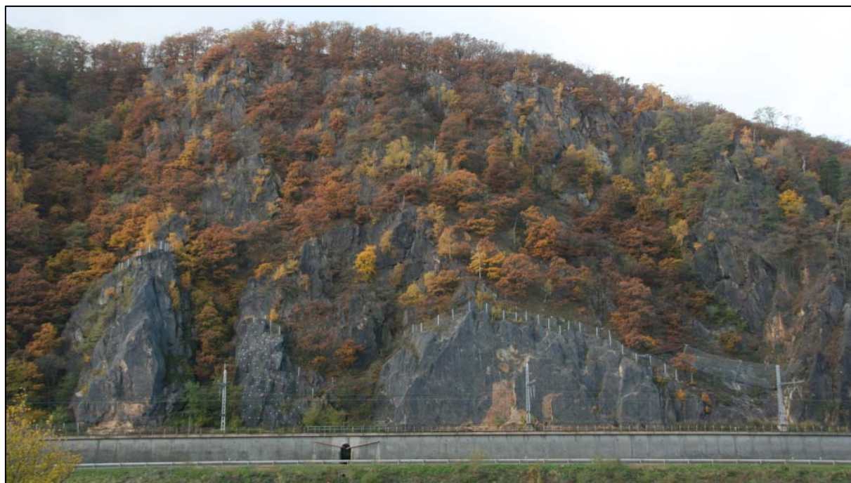
Obr. 3. Zajištění bezpečnosti u liniové stavby – I. tranzitní koridor – úsek v části Porta Bohemica - u Litochovic nad Labem – v pravé části snímku je vidět první dynamická bariéra instalovaná v ČR.
