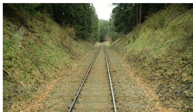
Obrázek 5: Oboustranný zářez tvořený strmými svahy, trať 149 Mariánské Lázně - Karlovy Vary, km 4,8, pohled směr M. L.
