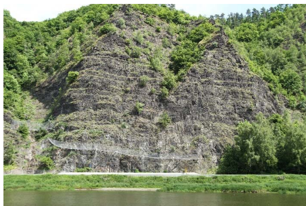
Obrázek 4: Pohled na výrazný skalní svah Zvolské homole nad silnicí II/1043 Vrané nad Vltavou - Praha po dokončení zajištění bezpečnosti, 2014
