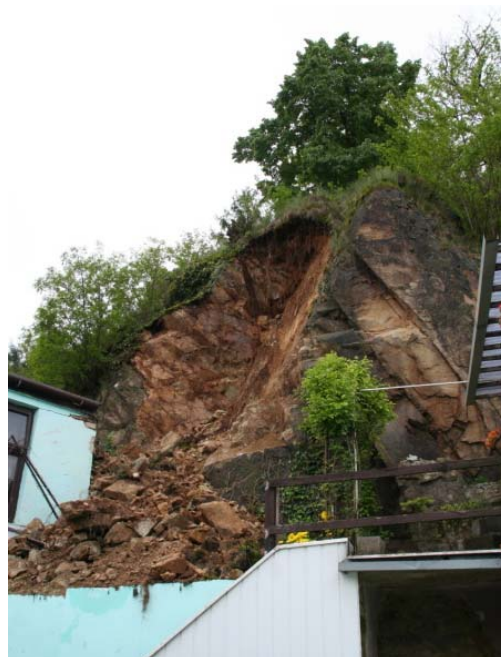
Obrázek 20: Zřícení části masivu na rodinný dům v Kuřimi, ulice Podhoří
