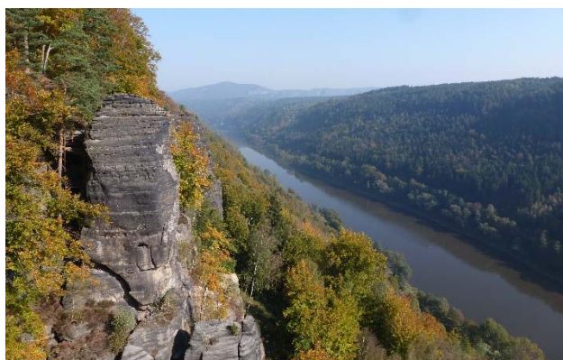
Obrázek 14: Pohled na objekt Žlebské jehly (1400 t – cca 700 m 3 ) nad údolím Labe, Dolní Žleb, trať Děčín hl. n. - státní hranice SRN, stav bloku před jeho následnou stabilizací v roce 2014
