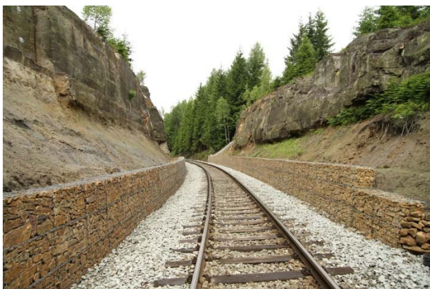
Obrázek 6: Oboustranný zářez po modernizaci úseku trati 081 - Čeká Kamenice - Jedlová, pohled směr Jedlová
