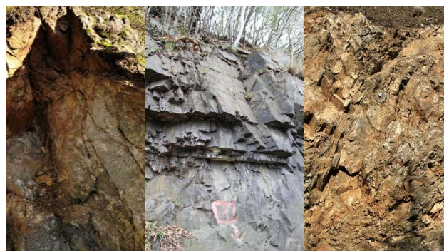
Obrázek 8: Příklad hornin skalních masivů, zleva granodiority Dolní Kounice, prachovce - břidlice Měchenice a pararuly Chrástice, horniny ve vyšším stupni zvětrání
