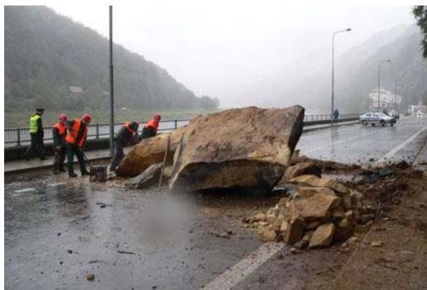
Obrázek 1: Řízený blok na silnici I/62 ve Hřensku v roce 2009, objem cca 10 m 3 , doba omezení provozu 3,5 roku, (Z. Vařilová, Správa NPČŠ)
